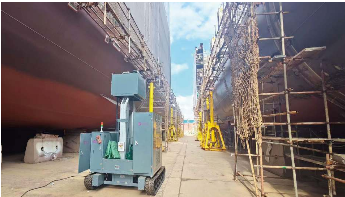
集装箱船合拢缝焊接项目-浙江 舟山
