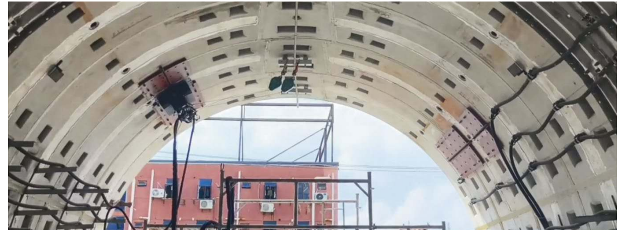
地铁隧道钢衬里修复焊接项目-上海
