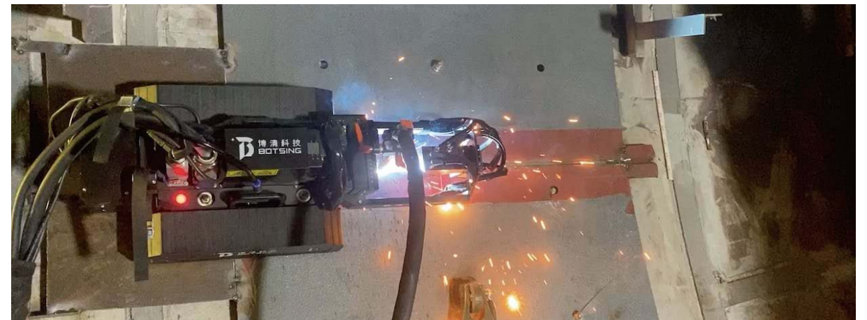
地铁隧道修复焊接项目-深圳
