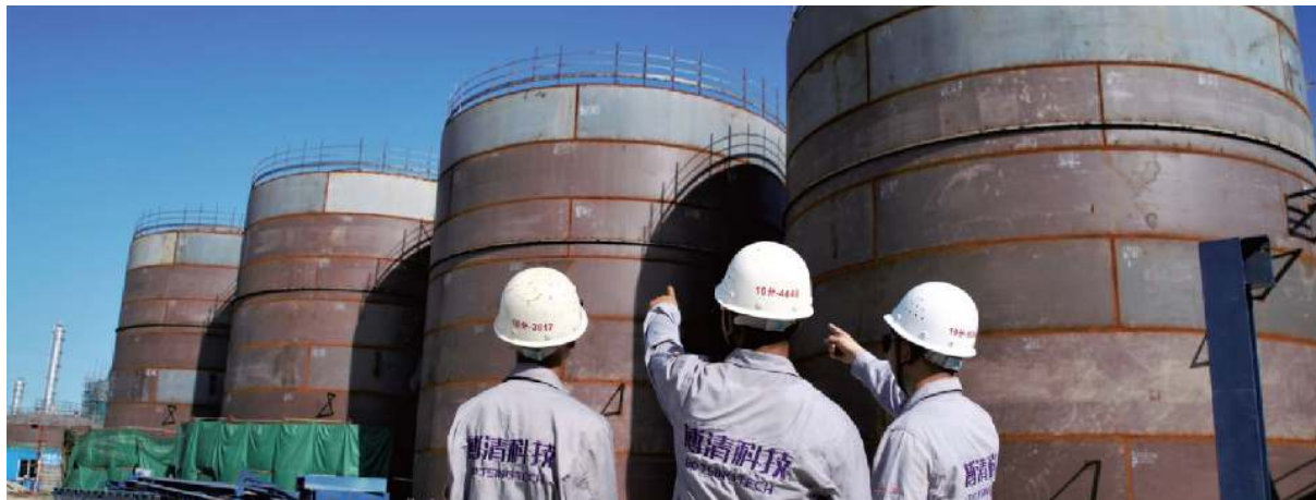
储罐焊接项目-广东 湛江
