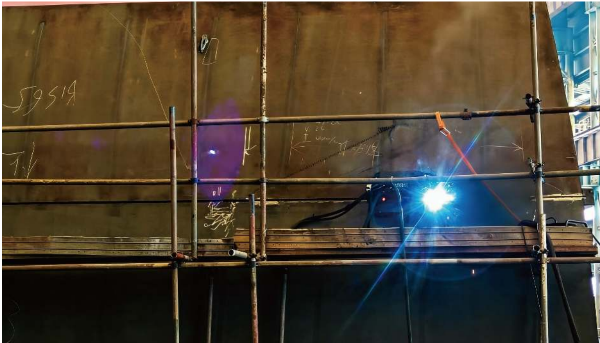
9Ni钢LNG罐焊接项目-辽宁 大连
