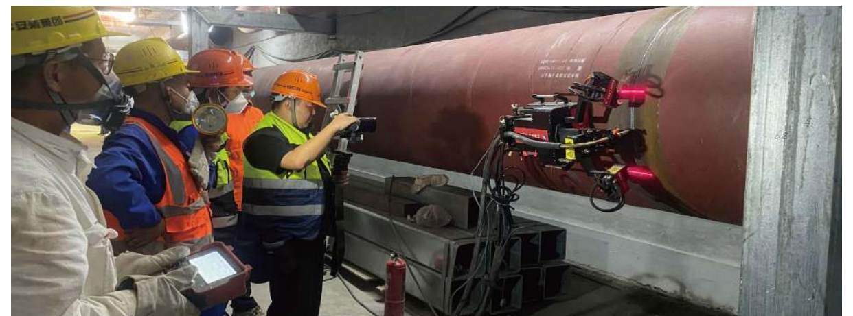
机场管廊焊接项目-上海
