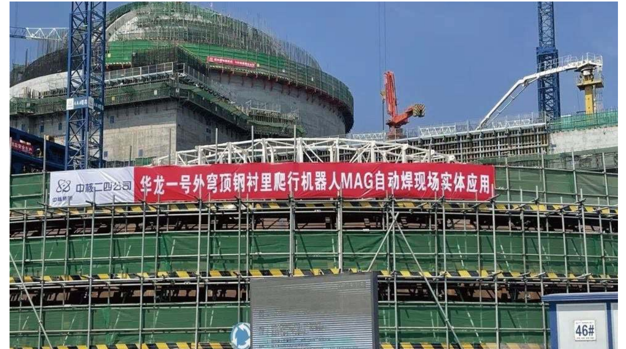
核电安全壳穹顶焊接项目-福建 漳州
