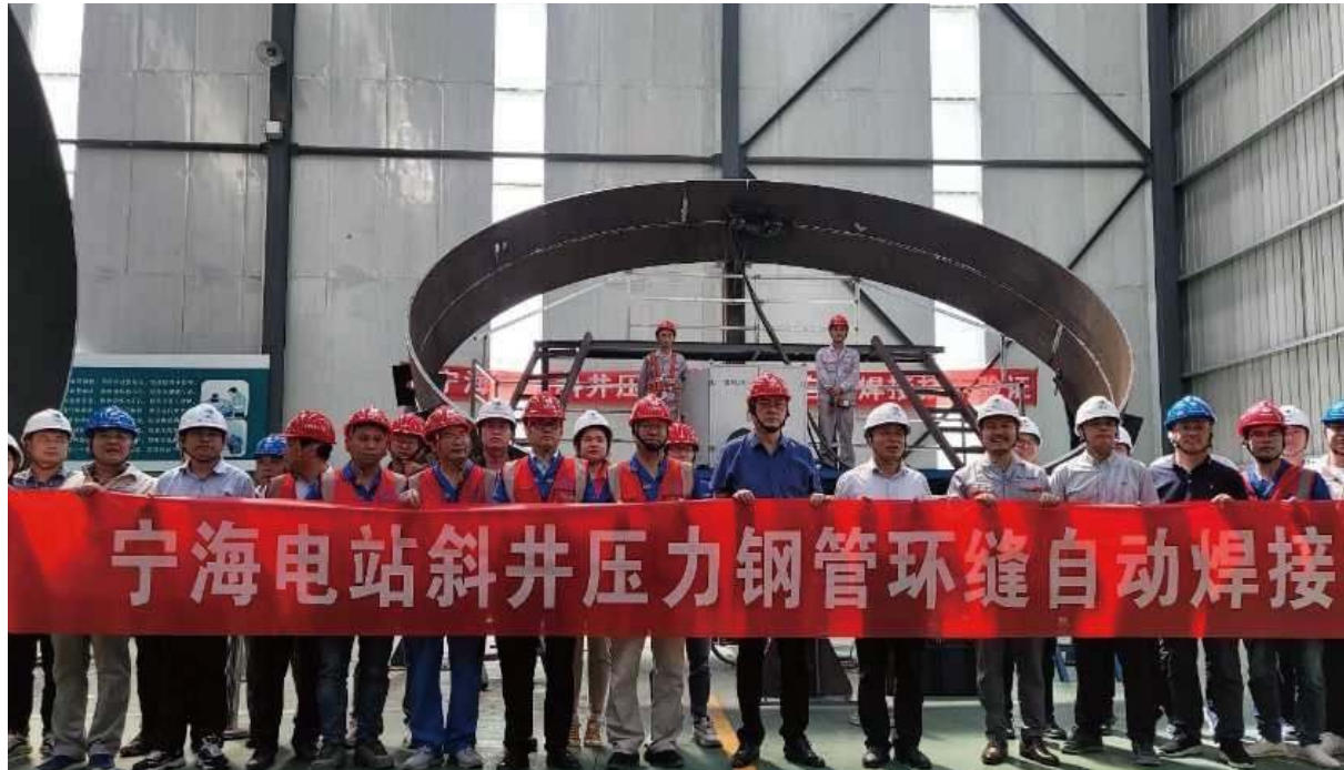
电站斜井压力钢管焊接项目-浙江 宁海
