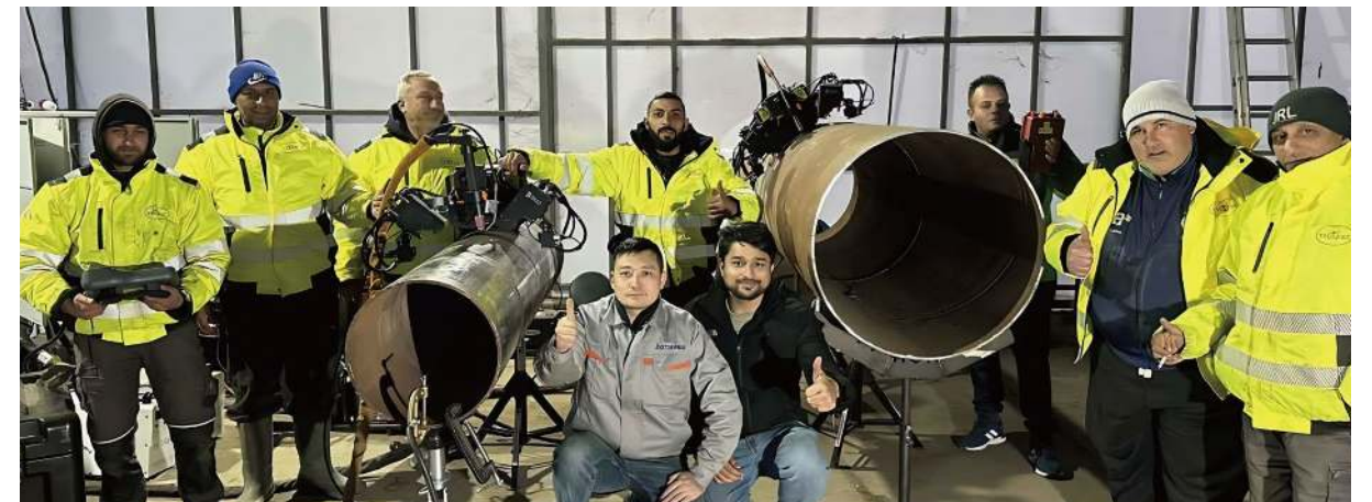
管道焊接项目-保加利亚
