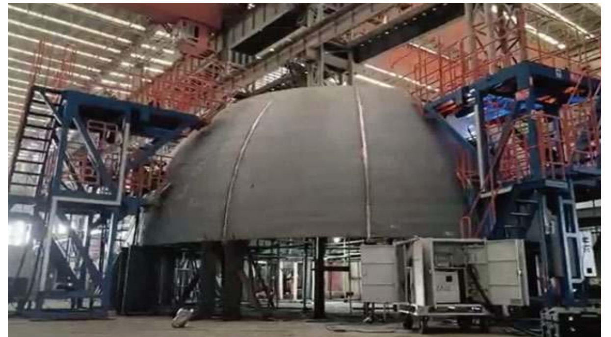
9Ni钢LNG罐焊接项目-江苏 南通
