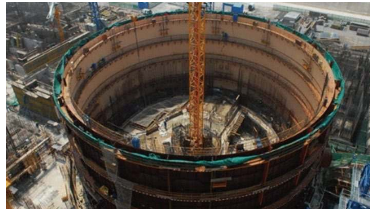
核电钢衬里焊接项目-浙江 嘉兴
